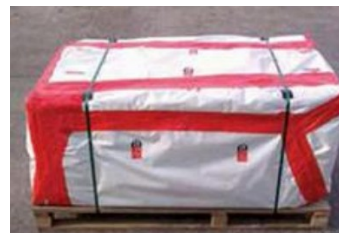
Exemple de palette contenant des déchets d'amiante
